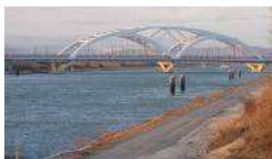
Bridge over the Rhône canal of the LGV Méditerranée.
