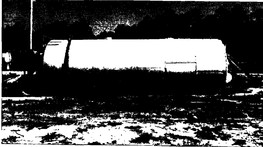
Fig. 2.2-1. Lime slurry tank.
