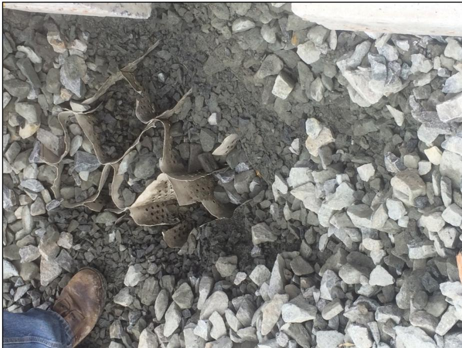
**Figure 65: Edge of Geocell Layer**
